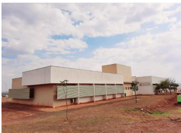
Prédio de Biomedicina e Enfermagem – Campus Jatobá – UFJ.
